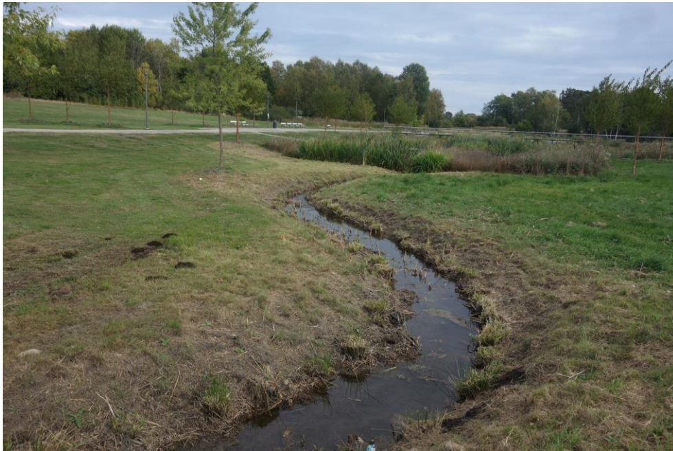
Figur 19. Dike i parkmark (Foto: Tyréns AB).
