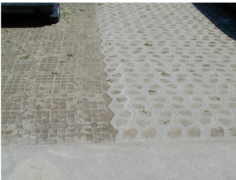
Figur 22. Genomsläppliga beläggningar med plast och betong (Foto: Tyréns AB).
