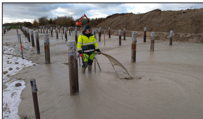
Det termiska området täcks med ett 40 centimeter tjockt lager isobetong. Detta för att behålla den 300-gradiga värmen inne i anläggningen.
