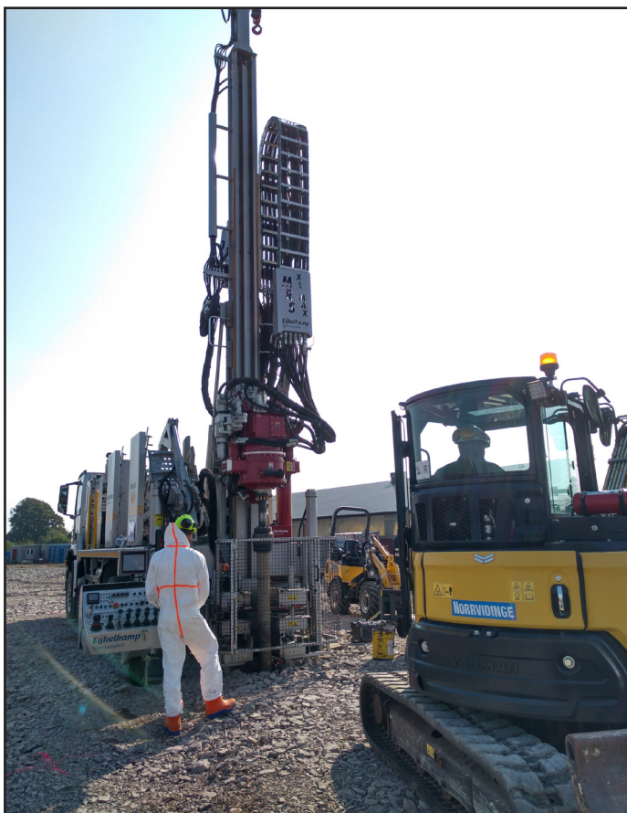
Med hjälp av ett par holländska borrhjuggar borraras 260 hål i den blivande termiska anläggningen under sex veckors tid.
